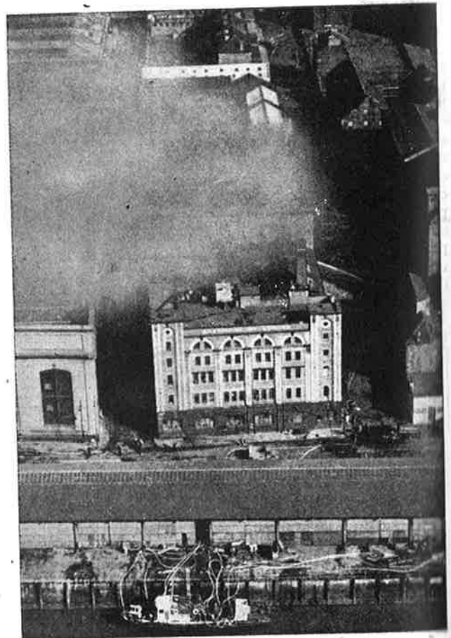
Una vista del almacén siniestrado.
