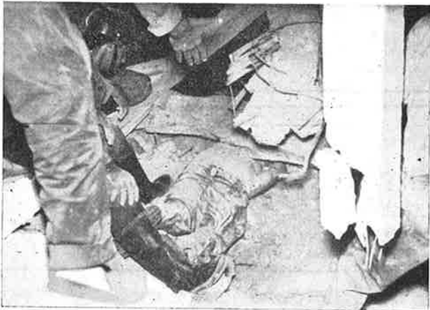
Lugar, dentro del edificio, donde se halló el cadáver del infortunado obrero.
